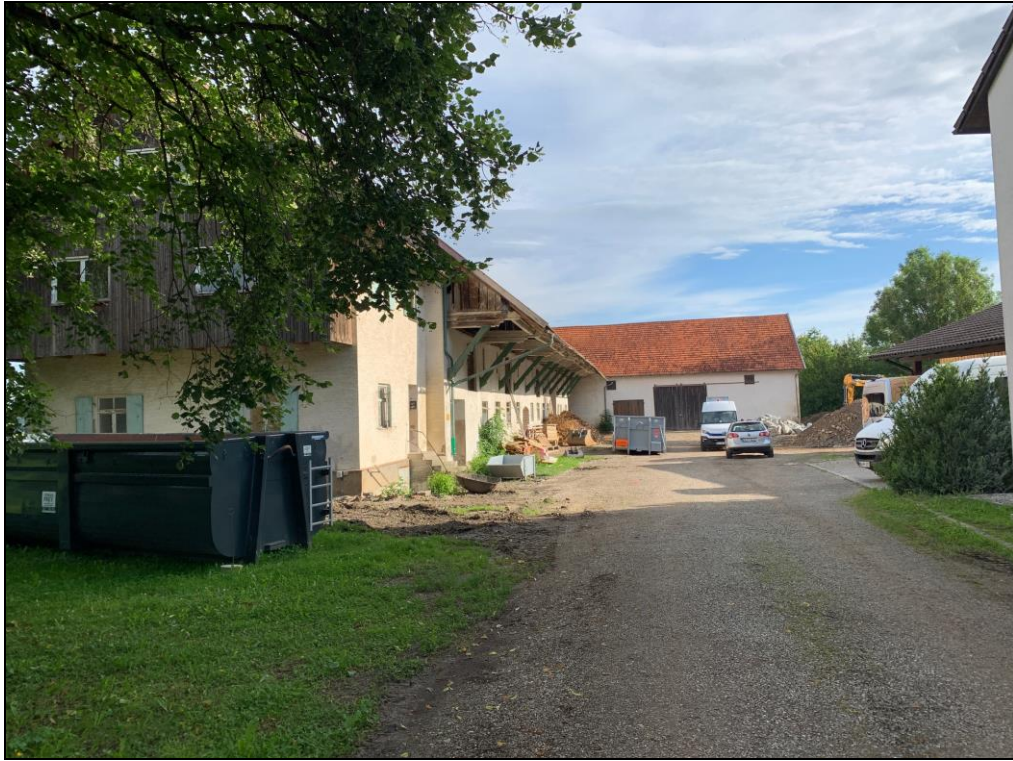
Bild 1: Baufläche am 03.08.2021 / Blickrichtung Norden
