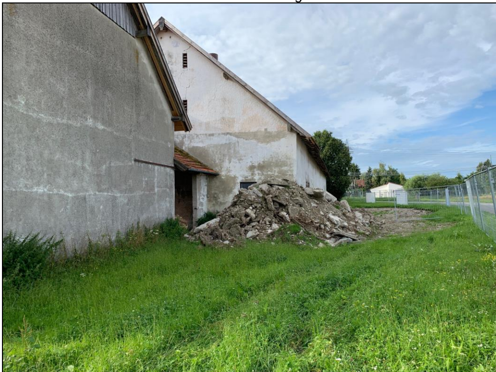
Bild 2: Baufläche am 03.08.2021 / Blickrichtung Süden
