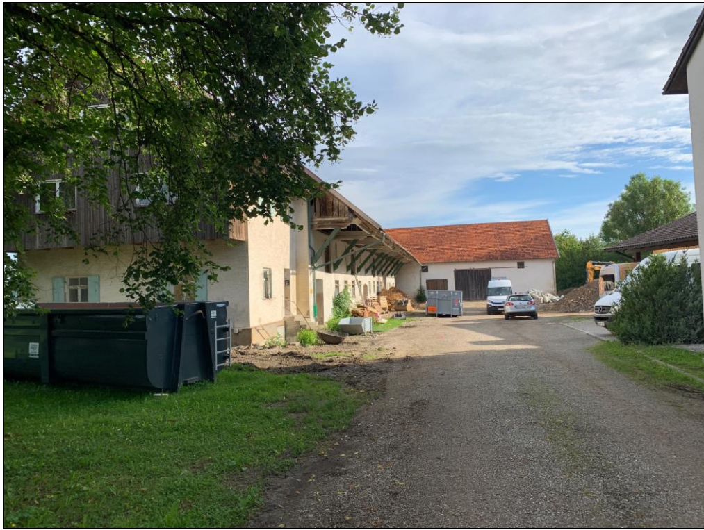
Bild 1: Baufläche am 03.08.2021 / Blickrichtung Norden
